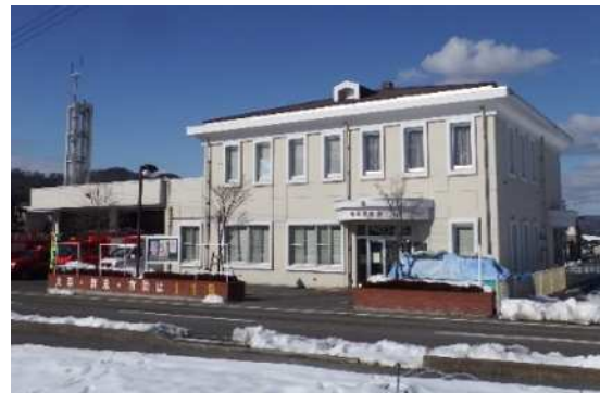
庁 舎(平成 5 年 2 月竣工)
